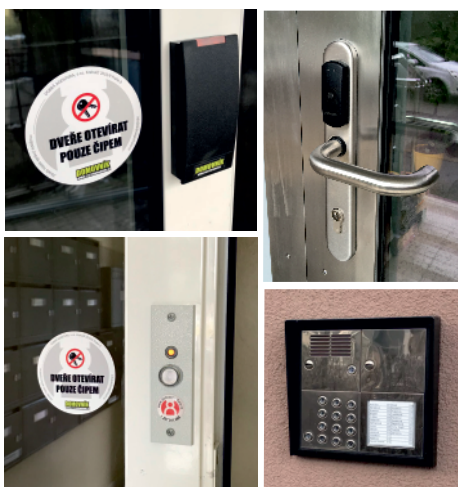
Fotografie z instalací
